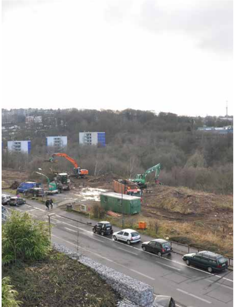
Beginn der Bauarbeiten für den Neubau auf dem Campus Griffenberg.
