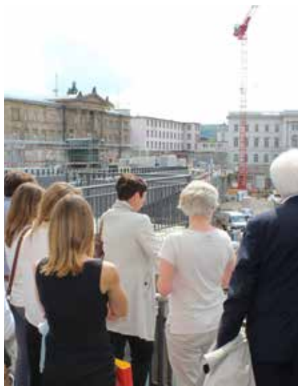
Die Aussichtsplattform bietet einen fantastischen Ausblick auf die Großbaustelle
